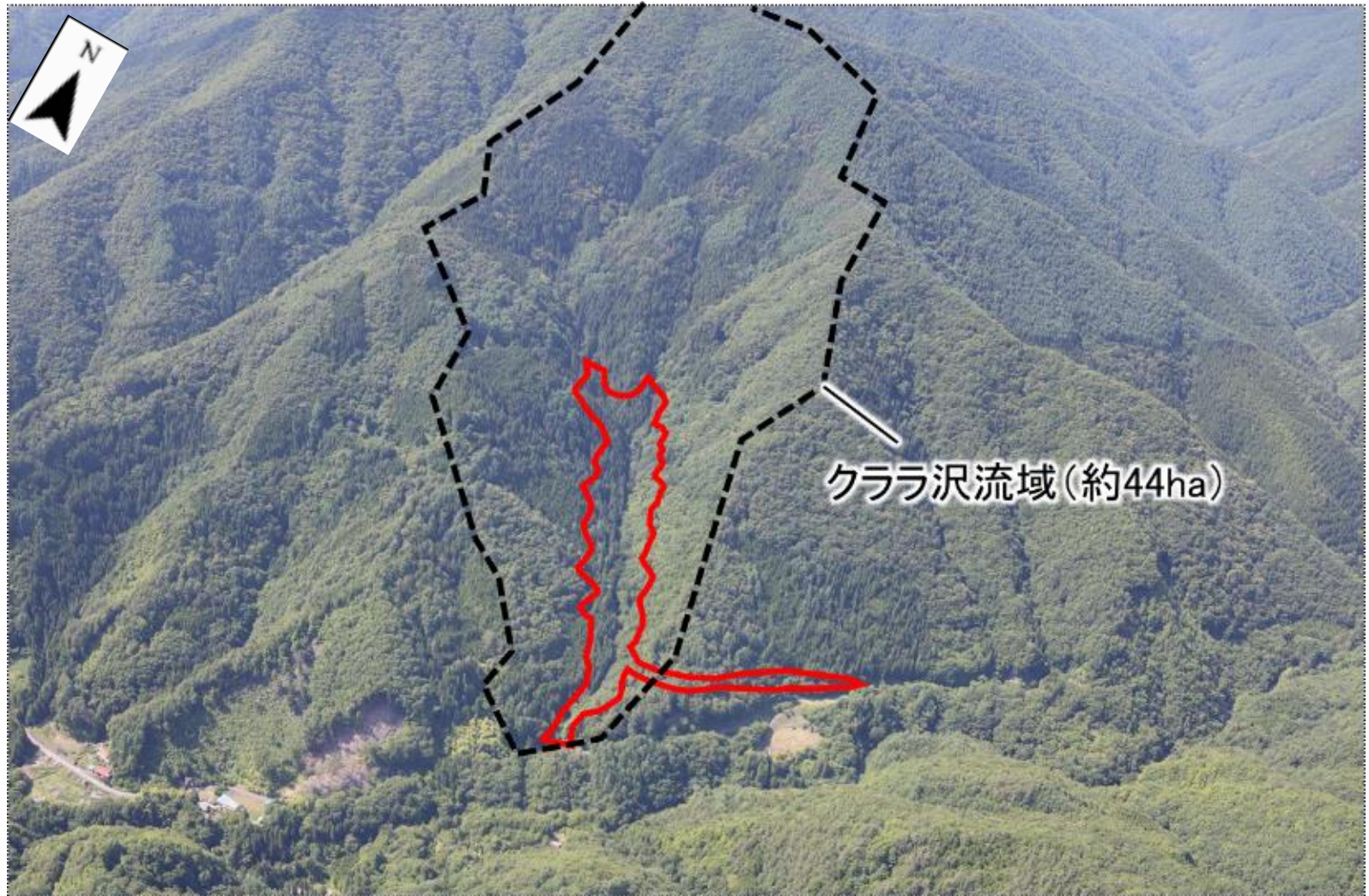
発生土置き場(クララ沢)計画地の工事前の状況
