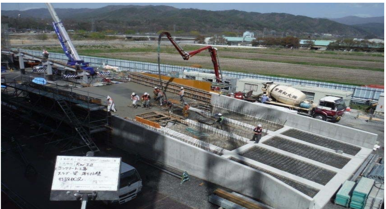
■コンクリート打設状況
