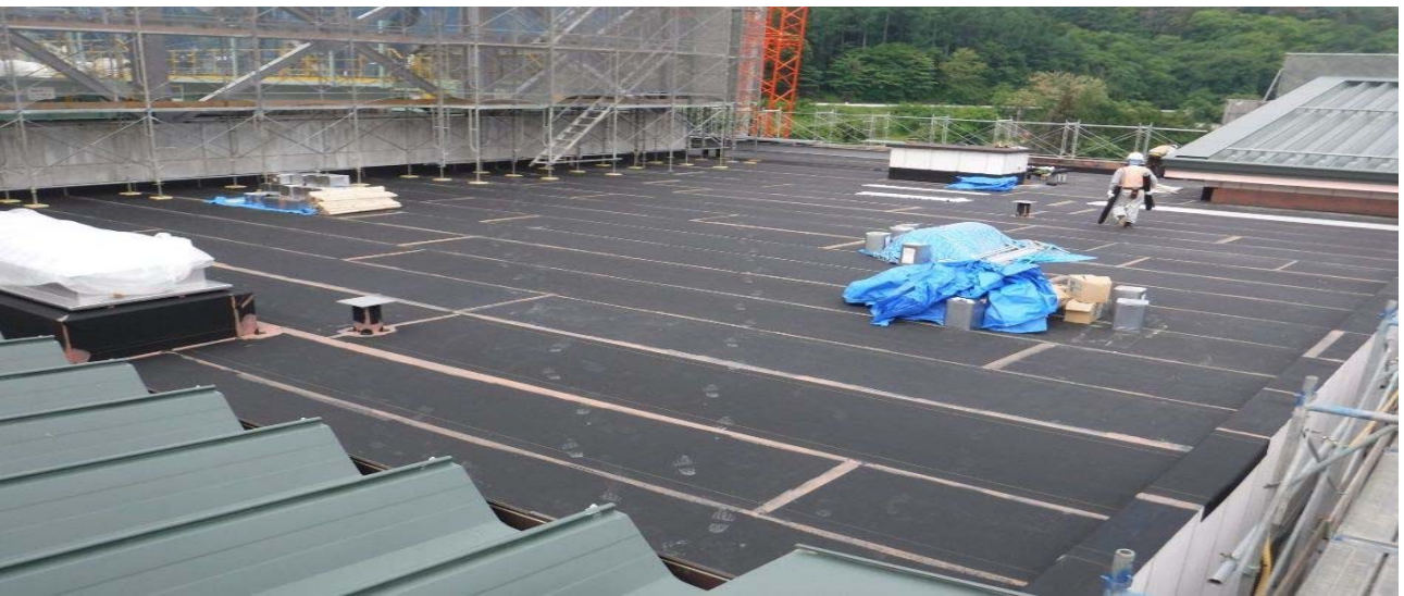
■屋根シート防水状況
