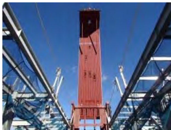
■ボイラ壁パネル取込状況
