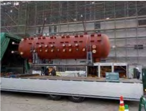
■ ボイラドラム搬入状況
