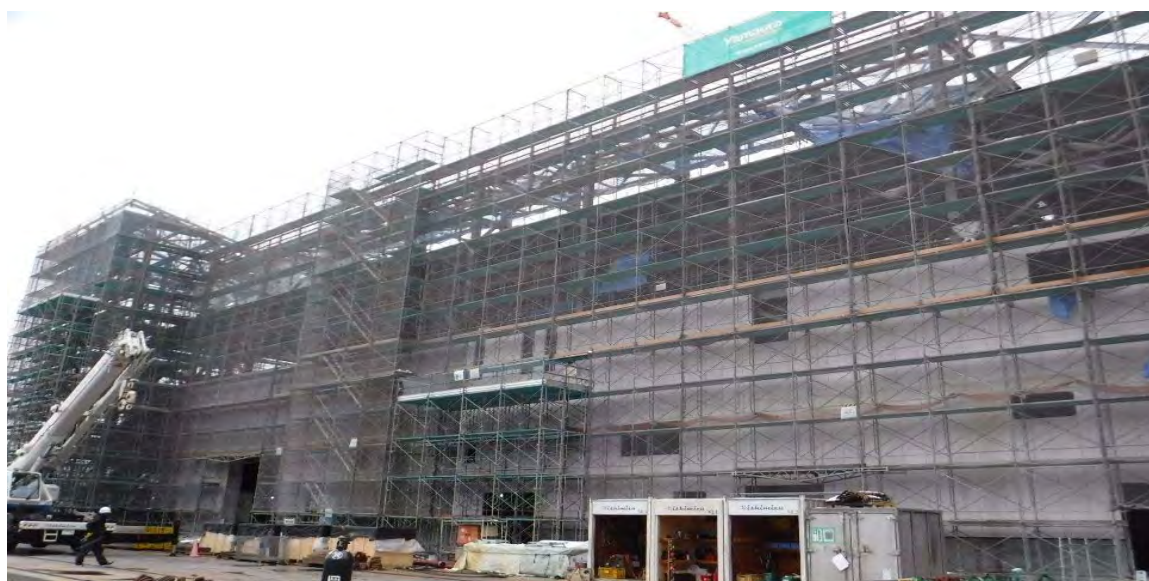
■西側外壁 ALC 設置状況
