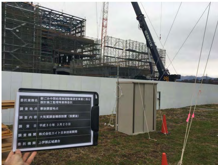
□大気質測定状況（全景）
