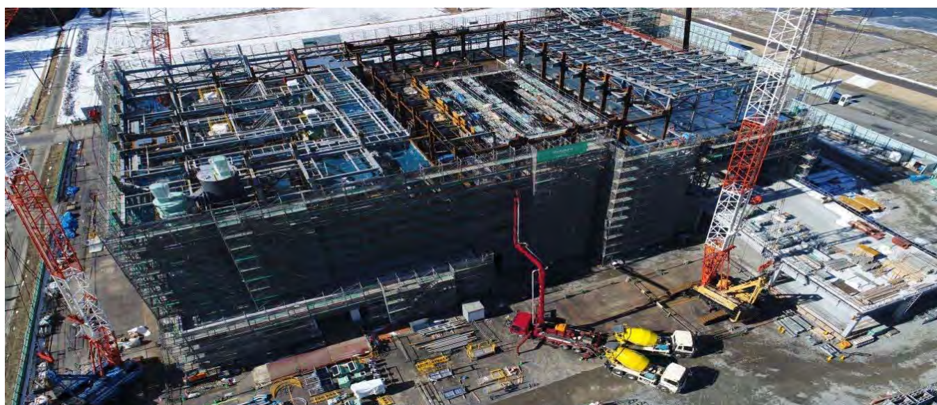
■1月末コンクリート打設工事
