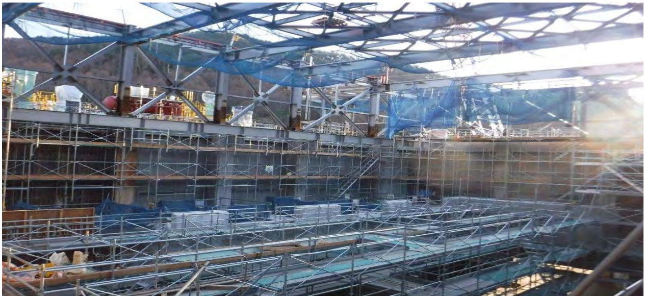
■内部型枠状況 ごみピット工区
