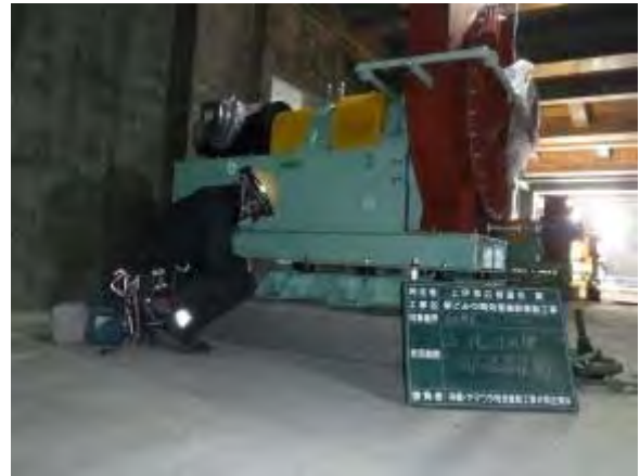
■ 押込送風機設定状況
