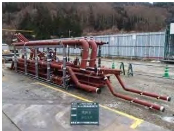
■ボイラ連絡管搬入状況
