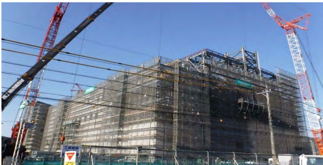
■鉄骨建方状況 炉室工区
