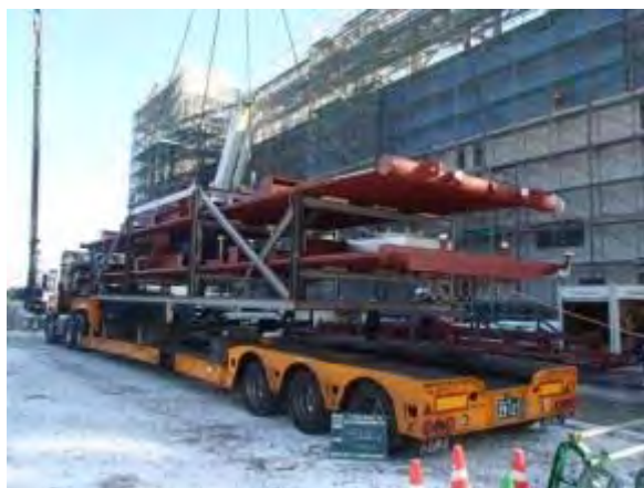
■ボイラ壁パネル搬入状況
