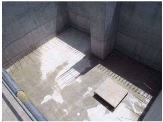
■ピット内部状況
