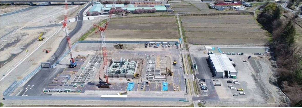
■基礎打設状況
