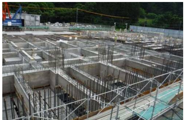
■基礎脱型完了
