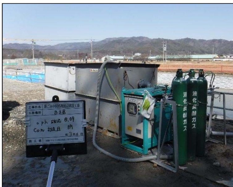
□コンクリート打設時
