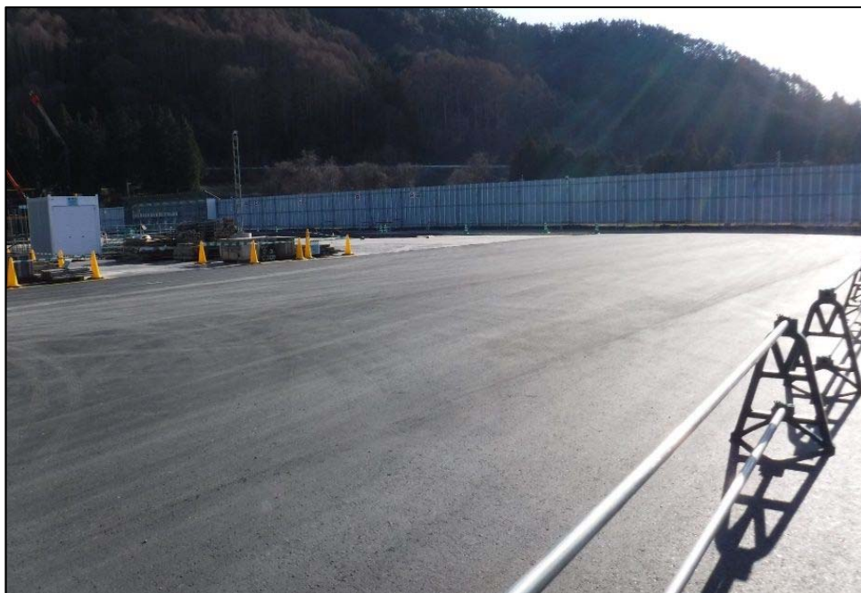
□場内仮設舗装実施
