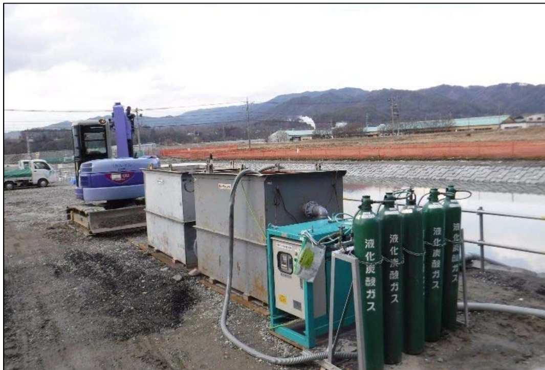
□炭酸ガス中和装置設置状況
