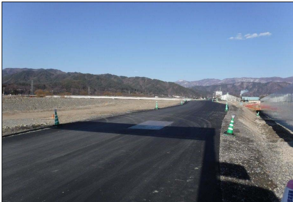
□導入路仮設舗装実施
