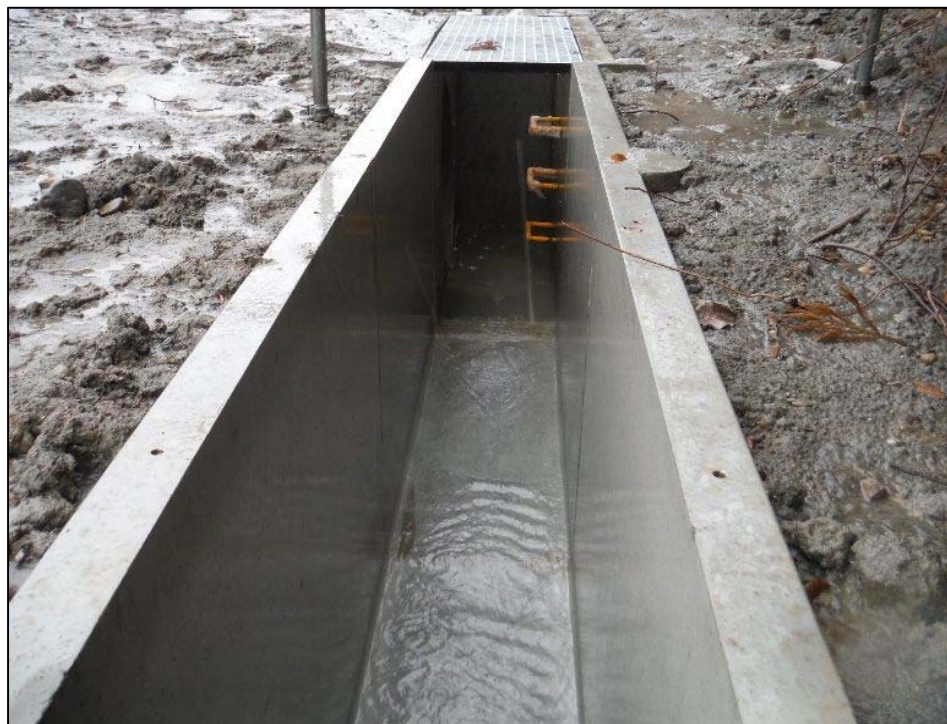
□調整池より放流水路状況写真
