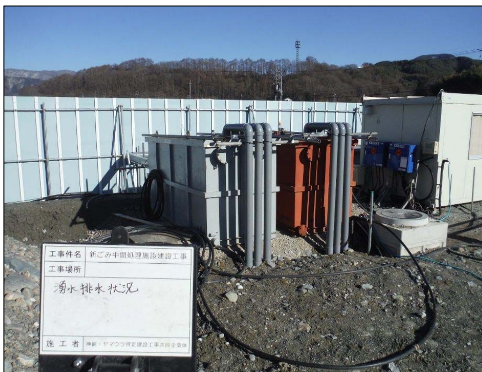
□湧水くみ上げ水槽
