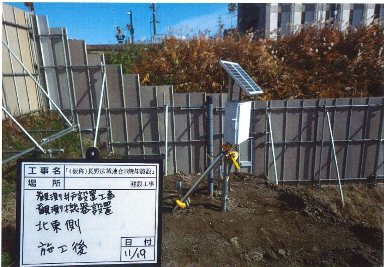
地下水水質・水位測定用井戸 設置状況②(北東側)
