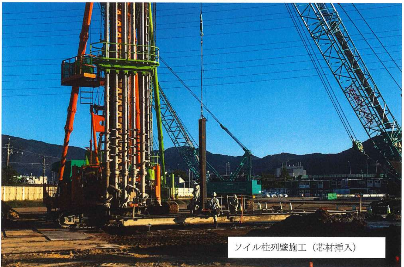
遮水壁設置状況(山留工事)②
