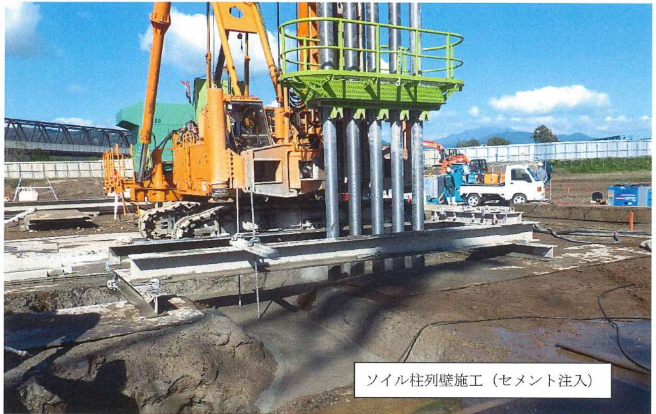
遮水壁設置状況(山留工事)①
