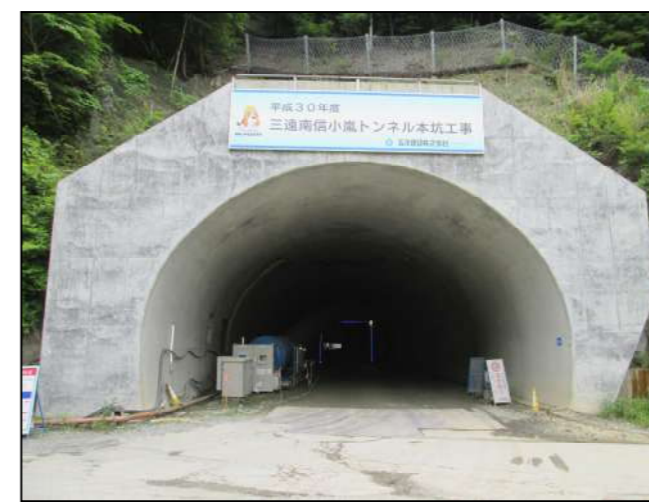
②トンネル本坑工事
