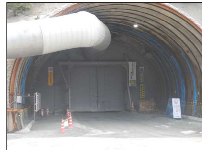
トンネル坑口 防音扉の設置
