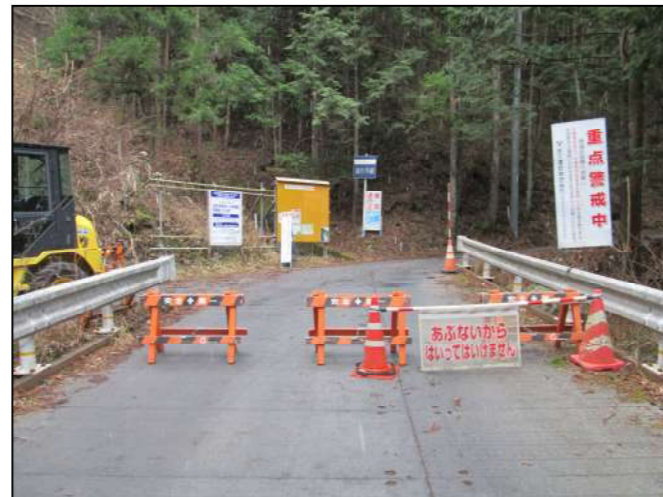
工事現場への立ち入り禁止柵
