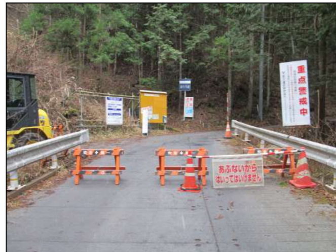
工事現場への立ち入り禁止柵
