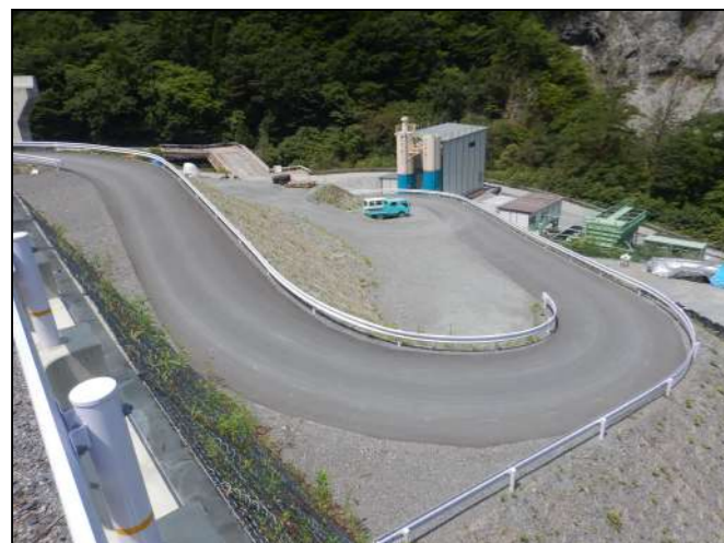
工所用道路の仮舗装
