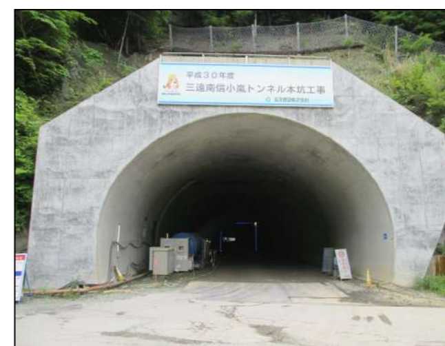
②トンネル本坑工事
