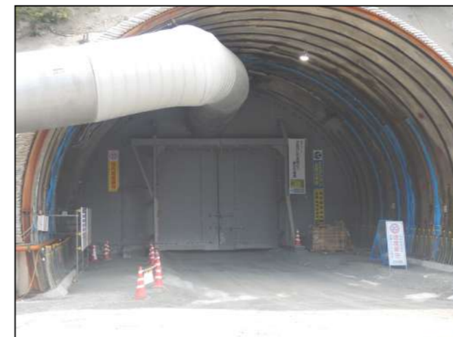
トンネル坑口 防音扉の設置
