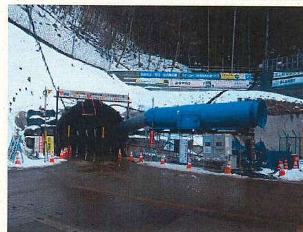
②調査坑坑口
