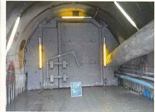
トンネル坑口 防音屏の設置
