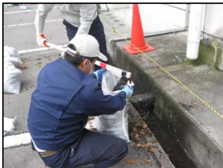
<除染作業の様子>
