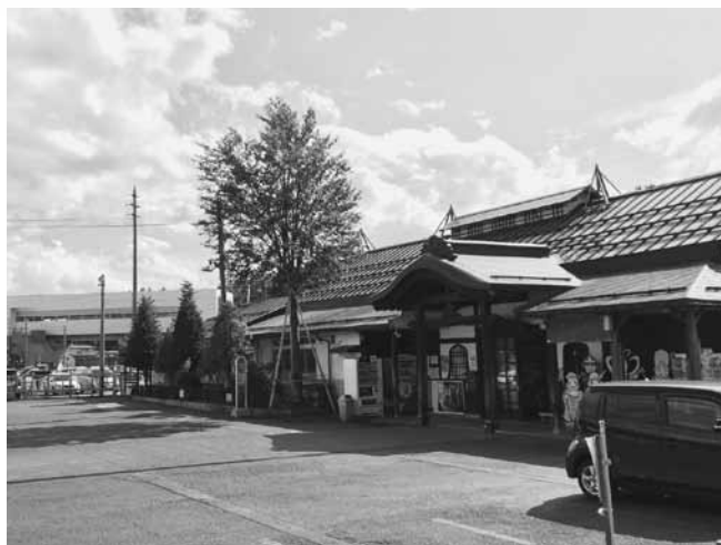
在りし日の飯山駅とブナの木：手前が旧駅舎で左奥が建設中の新駅舎（2014年6月13日撮影）
