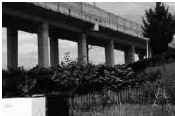
新幹線騒音調査風景(右下にあるのが集音装置)
