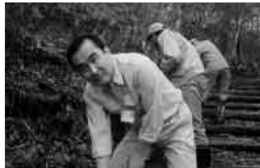
飯綱庁舎敷地整備の作業をする倉沢
