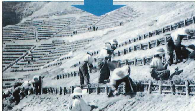
山腹緑化の状況（同上）
