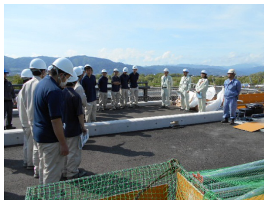
冠着橋建設工事現場
