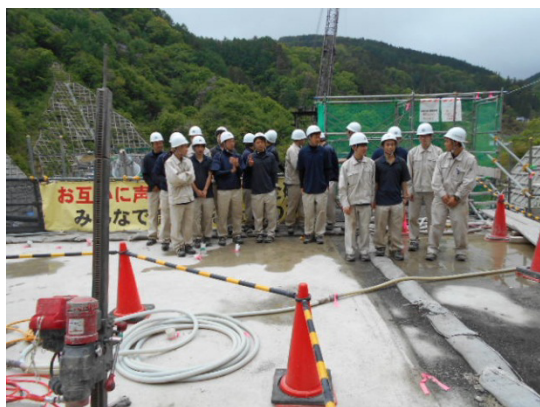
浅川ダム建設工事現場
