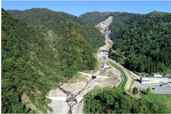
[栄村中条川 治山事業実施状況]
