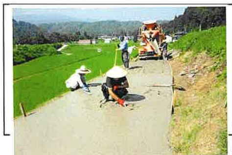
【生コン打設状況】
