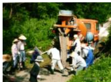
【農道の舗装作業】
