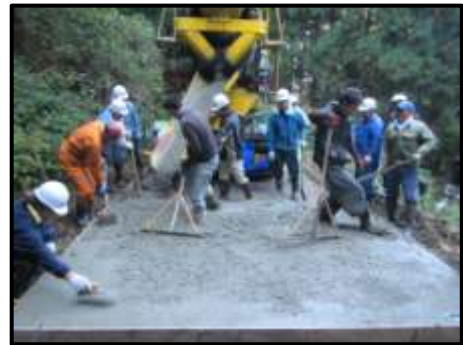
【農道舗装の様子】
