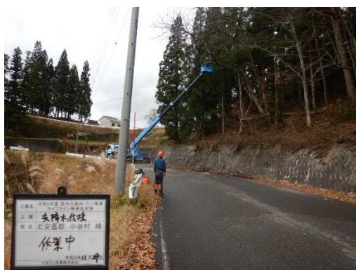
【送電線に隣接した倒木の恐れのある立木を伐採してライフラインの確保を図りました。】
