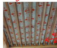
強度が要求される部分にカラマツ2×10材を使用（天井部分の拡大）
