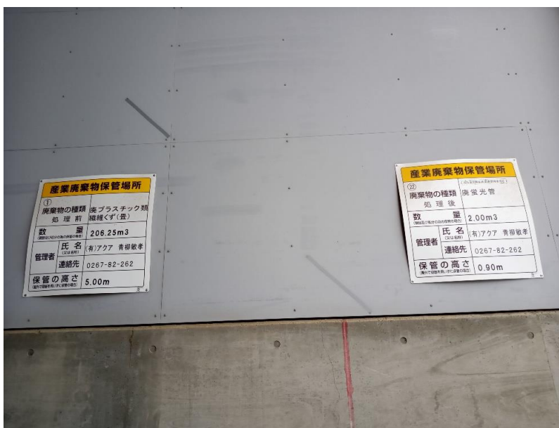
中間施設視察 場所 有限会社アクア NO、6 産業廃棄物保管場所 標識
