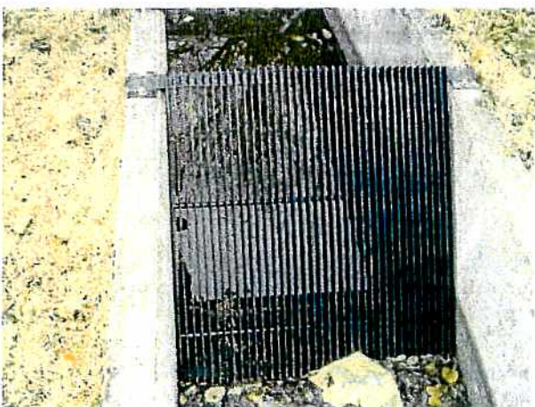
装置2 (拡大) 逸出防止スクリーン 開口 20 mm
