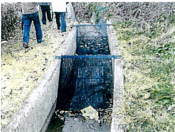
装置2 (手前側) 逸出防止スクリーン 開口 20 mm
