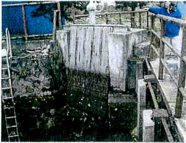
装置 1 スクリーン (既存) 開口 25mm
