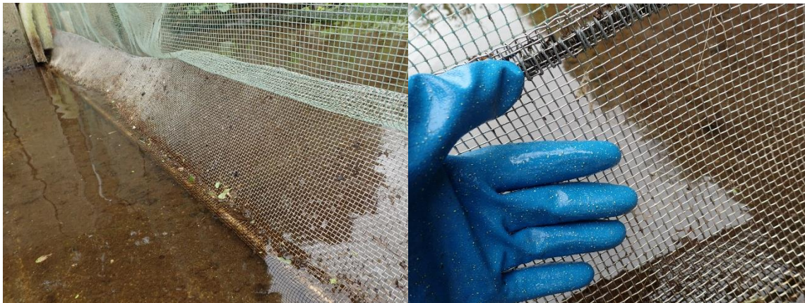
図 2 網地の下部部分をステンレス製に交換した逸出防止装置
