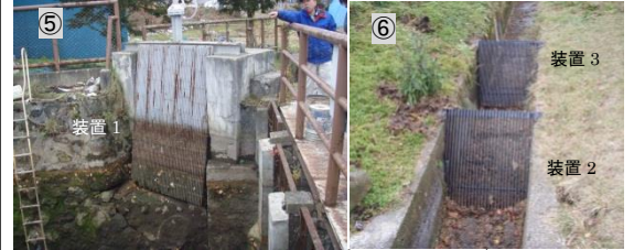
御小屋用水路 装置 1、2、3 (スクリーン)
