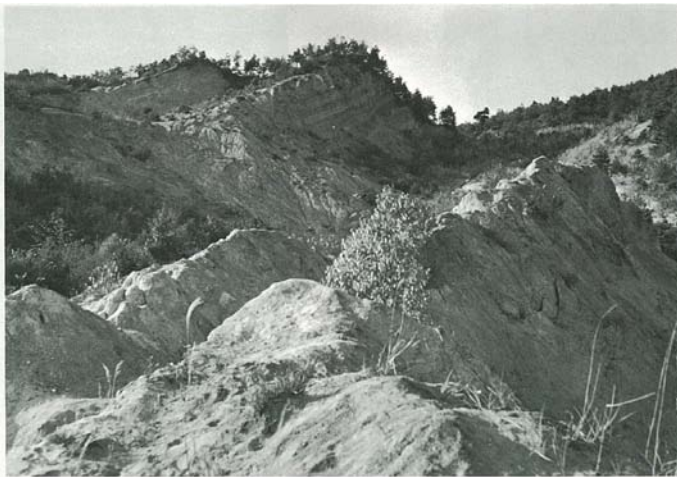
写真-5 地すべり地最上部。昭和24年5月撮影
