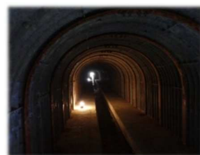
排水トンネル
