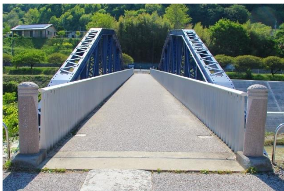
りんどう橋 (東側からのぞむ)
