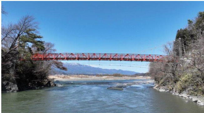
北の城橋（下流から）
