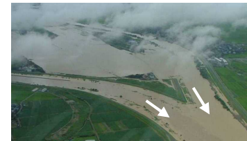
平成23年7月新潟・福島豪雨 長野市西野地先における浸水被害状況【信濃川(下流)】
