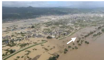
令和元年東日本台風 長野市穂保地先の堤防決壊、浸水被害状況【千曲川】
