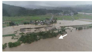
令和元年東日本台風 新潟県小千谷市内における浸水被害状況【信濃川(中流)】
