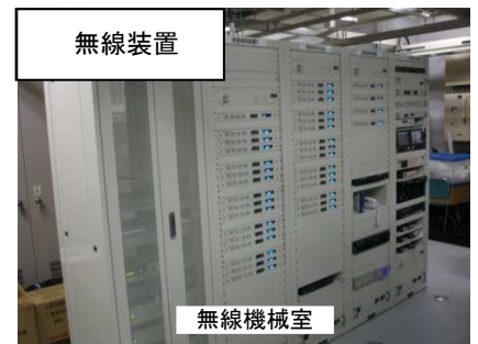
無線装置 無線機械室 県庁局（長野県消防課）
