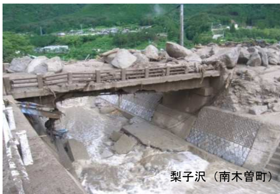
土石流による被害状況（平成 26 年 7 月発生）
