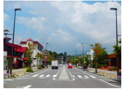
【無電柱化完了後（軽井沢駅前）】
