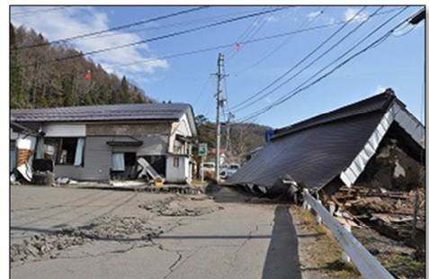
【長野県神城断層地震における被災状況】
