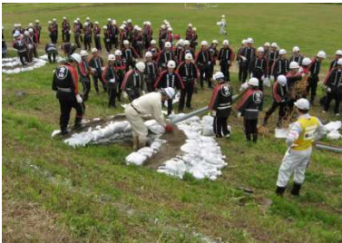
（月の輪工法の訓練（飯山市））（行政と住民による土のう作り訓練（岡谷市））（避難経路の再確認（岡谷市））
