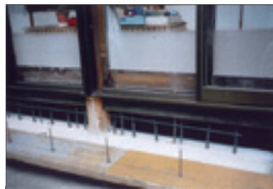
鉄筋コンクリートの布基礎設置
