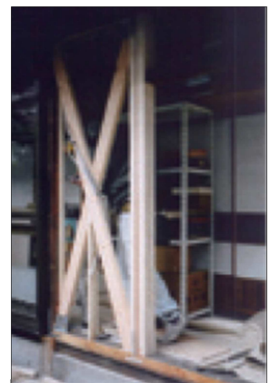
筋かい取り付け状況
