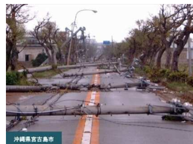
【台風による電柱倒壊（国土交通省 HP より）】
