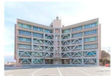
公共施設耐震対策事業 飯田合同庁舎
