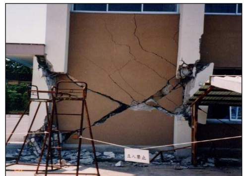
（被災建築物の状況）
