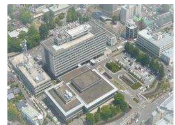
公共施設耐震対策事業 県庁本館棟・議会議棟
