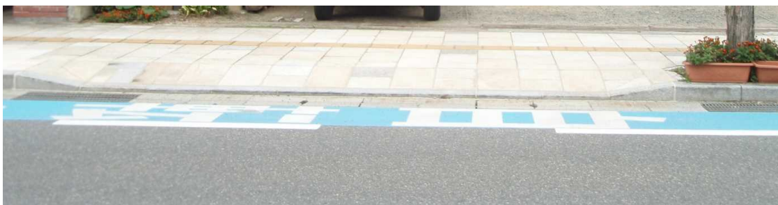
歩道切り下げ工事実施後：安全な状況
