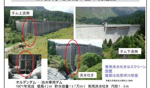
流木対策のスクリーンが下端から天端まで設置されている。
