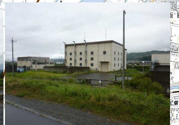
浅川第2排水機場(30m 3 /s)
