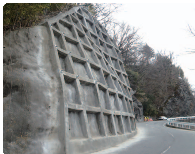
芝平高遠線 法面補修工事後（伊那市）
