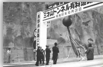
三才山トンネル有料道路 (開通式)
