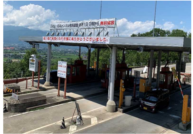
松本トンネル有料道路
