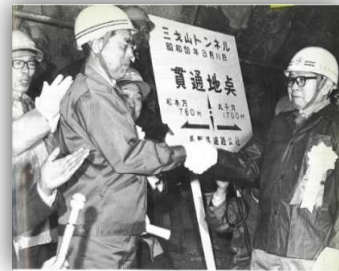
三才山トンネル貫通時(S50.3)の状況
