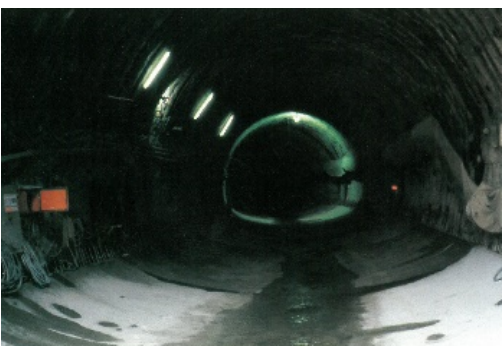
インバート(底盤コンクリート)工
