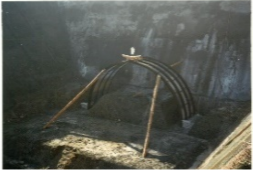
トンネル掘削前
