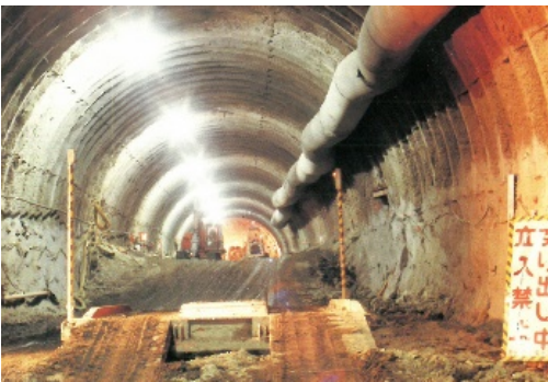
鋼製支保工 コンクリート吹付工
