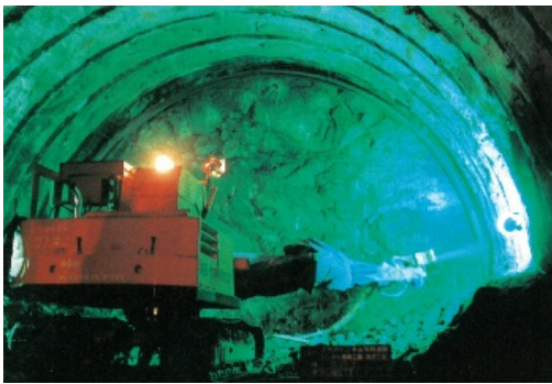
コンクリート吹付工
