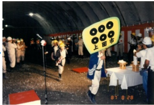
トンネル貫通(昭和62年8月)
