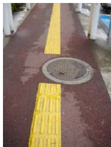
(右) 視覚障がい者誘導 ブロックの不適切例 出典: 国土交通省 HP
