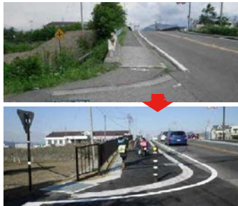
(左上下) 波打ち歩道の改善例 (国道 403 号 須坂市幸高)
