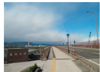
五輪大橋有料道路
