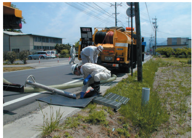
〔側溝清掃状況〕
