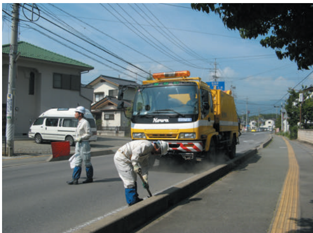
〔路面清掃状況〕
