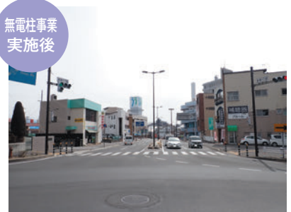
(主) 岡谷(停)線 岡谷市 本町
