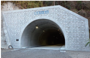
(国) 418号 天龍村 福島トンネル (施工状況)
