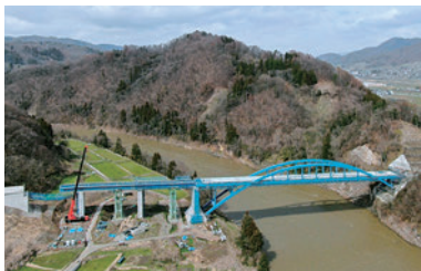
(一) 豊田中野線 中野市 笠倉～壁田 (施工状況)
