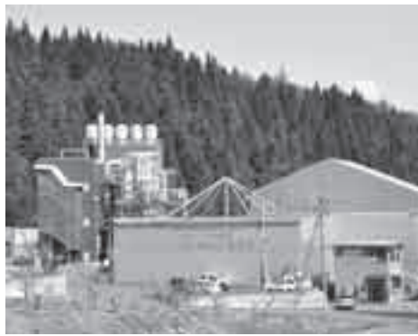
長野森林資源利用事業協同組合 いづな お山の発電所 木質バイオマス発電施設 【出力: 1,300kW ボイラーの蒸気でタービンを回し発電しています。】
