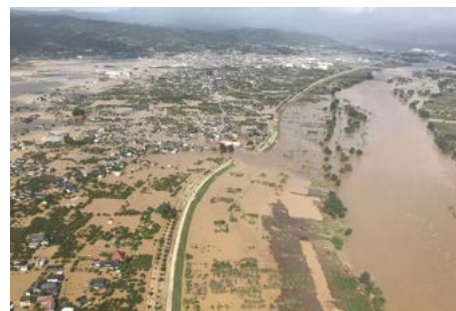
令和元年東日本台風で決壊した堤防
