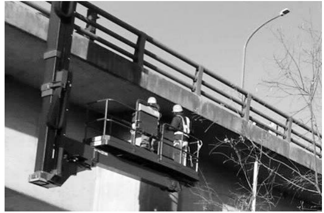
橋梁の点検作業
