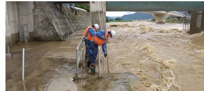
令和元年東日本台風翌日の取水口除塵作業(上田農水頭首工)
