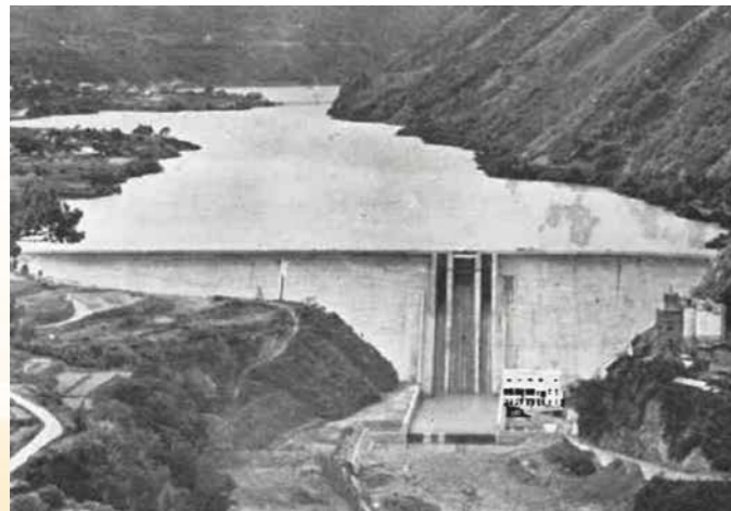
美和ダムと美和発電所(伊那市)
