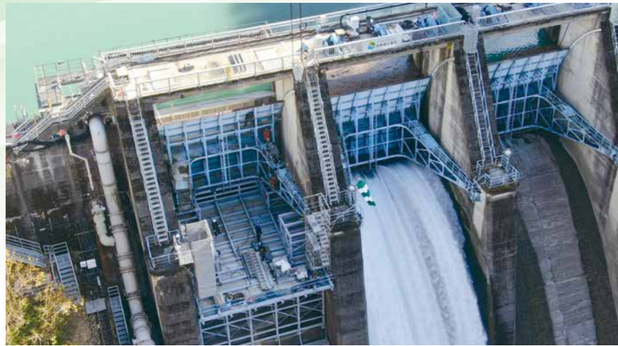
ゲート改修工事中の高遠ダム（伊那市）
