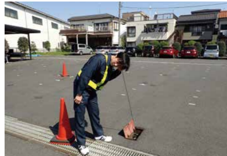
音聴棒による漏水調査
