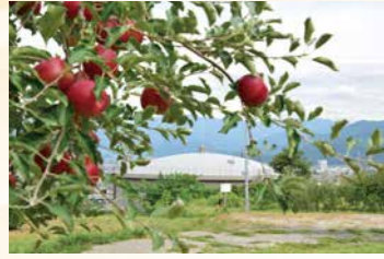
篠ノ井調整池 (川中島水道管理事務所管内)
