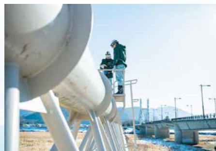
千曲川水管橋の定期点検
