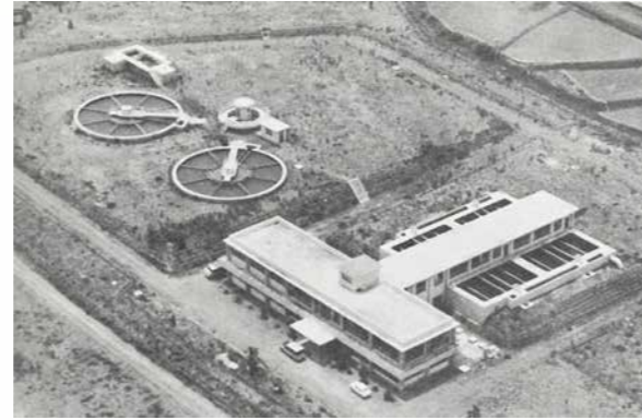
上田水道管理事務所と諏訪形浄水場(上田市)
