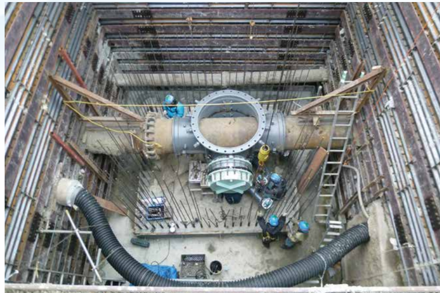
新しい浄水池への送水管分岐工事(諏訪形浄水場)
