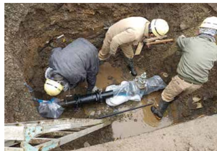
破損した管路の修繕工事
