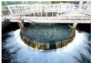
本山浄水場着水井 (松塩水道用水管理事務所管内)
