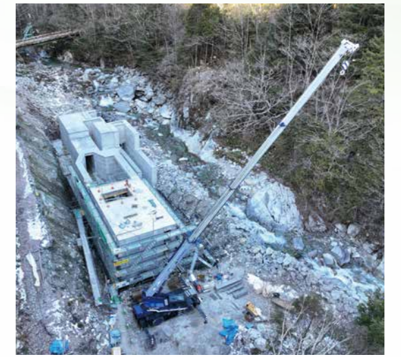
取水口建設工事
