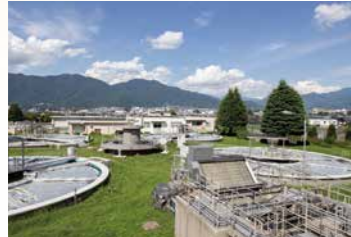
諏訪形浄水場沈殿池 (上田水道管理事務所管内)
