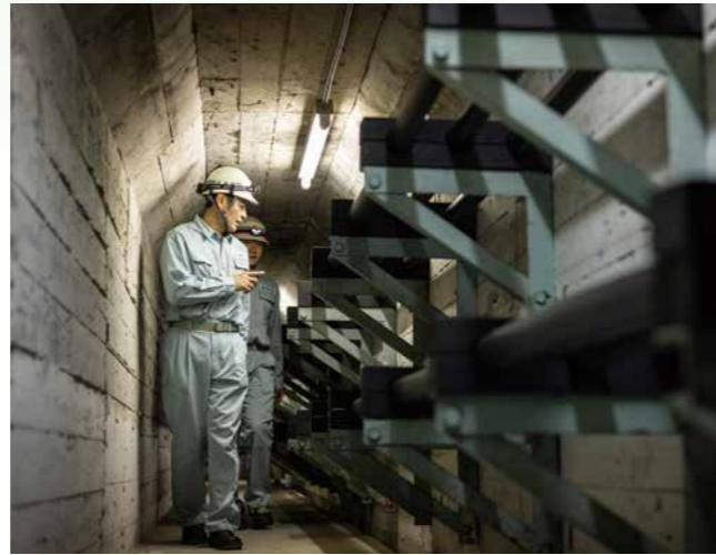
発電所監査廊点検
