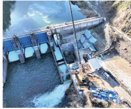
新規建設工事中の湯の瀬とおしき発電所（長野市）
