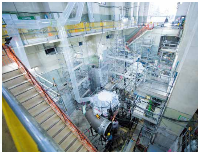
水車据付工事
