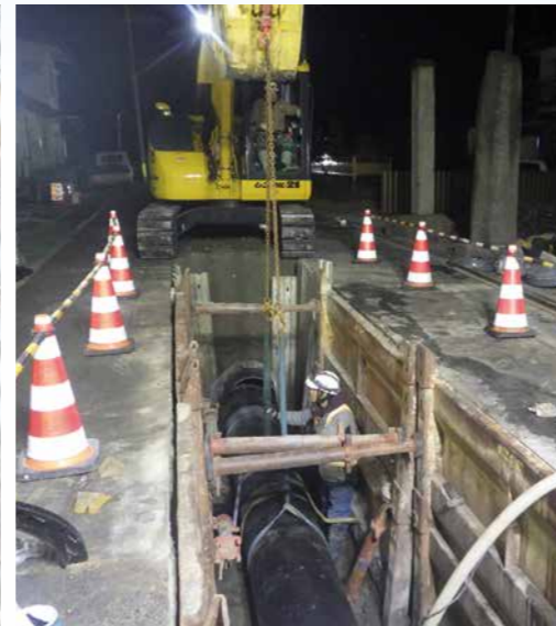
送水管敷設工事(長野市塩崎地区)
