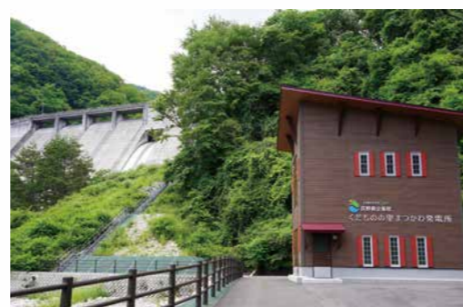
くだものの里まつかわ発電所 (南信発電管理事務所管内)
