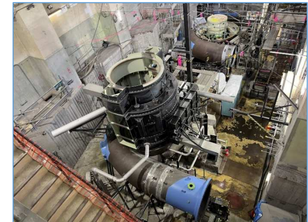
発電所内部(水車据付状況) (R6.1)
