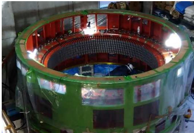
発電機(コイル)の組立状況 (R6.2)
