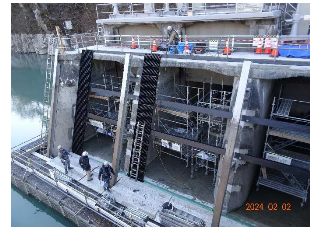
取水口(高遠ダム)の改修状況 (R6.2)
