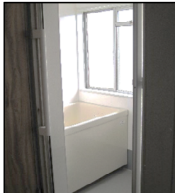
パネル張り、床防水
