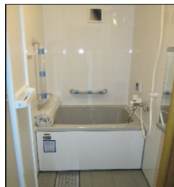
ユニットバス設置
