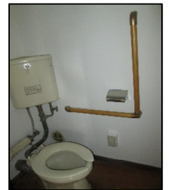
トイレ内手すり設置
