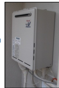
給湯器設置 （3点給湯：浴室、台所、洗面）
