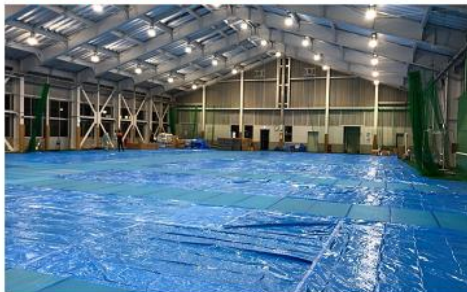
養生設置完了 (10月15日)
