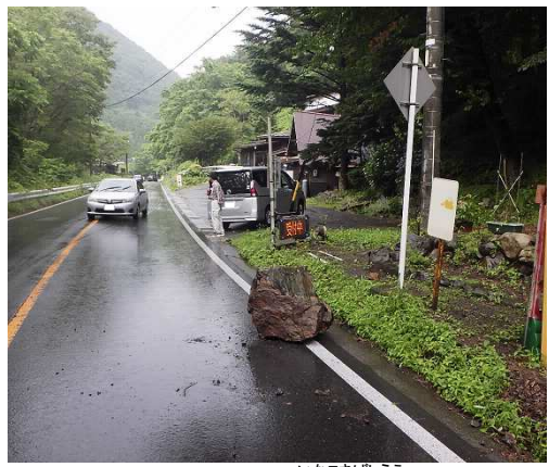
いなこぎほしうえ 一般国道158号 松本市 稲核橋上(令和元年7月)
