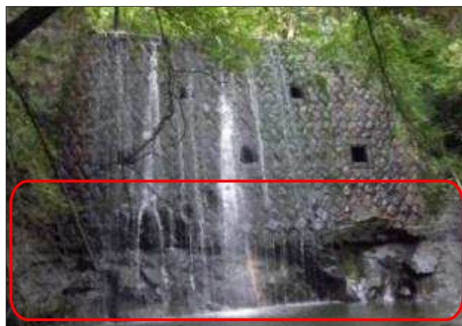
砂防堰堤の基礎洗掘
