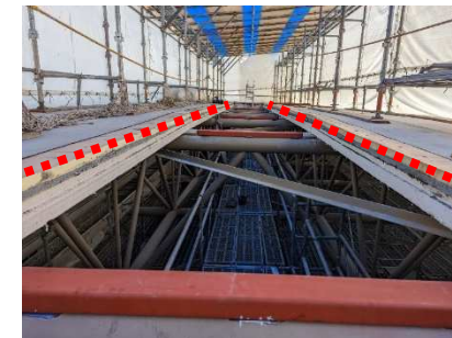
工事中の状況
