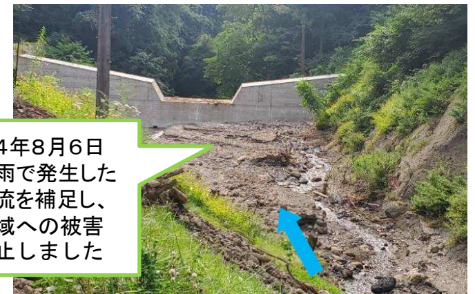
土石流発生後 (R4.8.8撮影)
