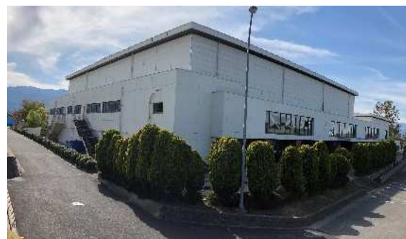
体育館（広域防災拠点）
