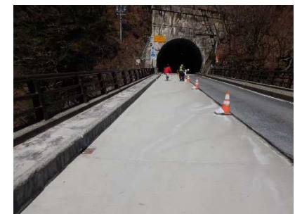
対策後: 床板補修完了
