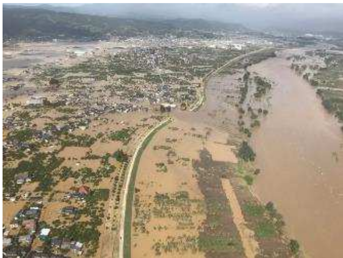
R元.10 東日本台風により千曲川堤防が決壊 (一)千曲川 長野市 穂保
