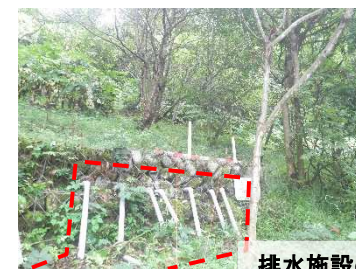
排水施設の破損
