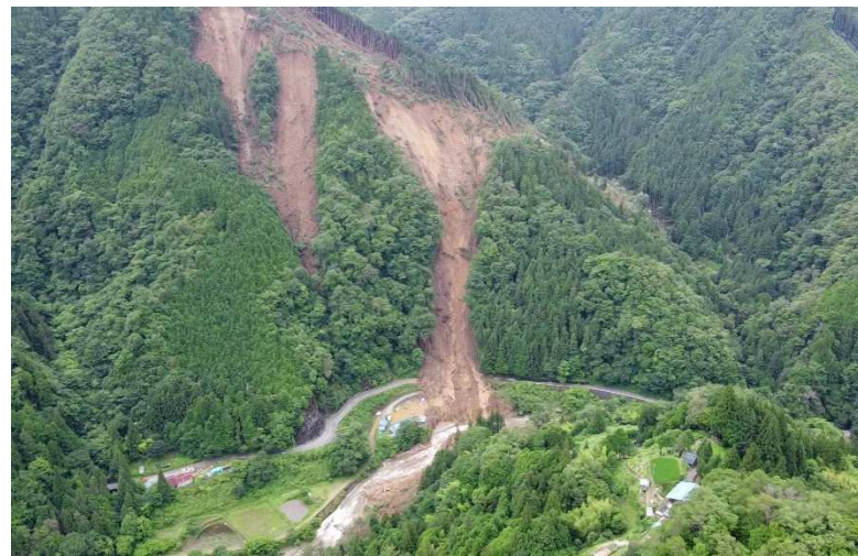
令和2年7月豪雨により大規模な山腹崩壊が発生 (国)418号 天龍村 足瀬
