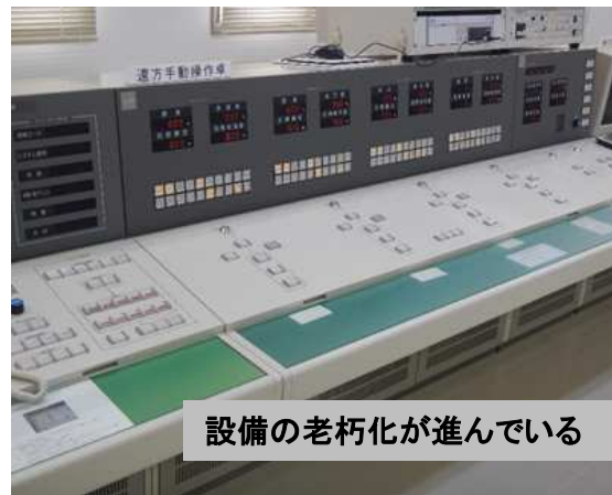
更新前のダム管理用制御処理設備
