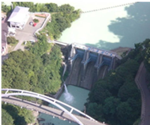
(耐震性能調査を実施した企業局管理の高遠ダム：伊那市)
