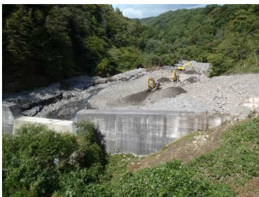
（二次災害発生防止のための応急工事） 御嶽山火山噴火に伴う土石流に備え 砂防堰堤の除石を実施（木曾町湯川）
